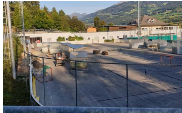
Renovierung des Eislaufplatzes nimmt Gestalt an
