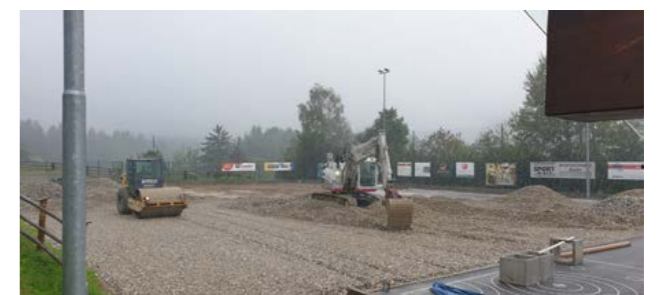
Bauarbeiten beim Sportplatz in Issing
